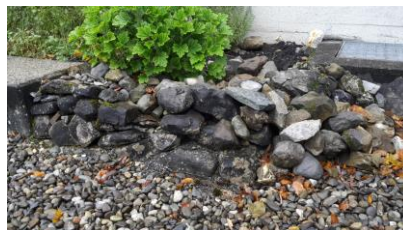
Abschluss mit einer Trockenmauer
